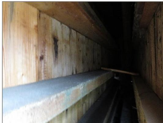
**Abbildung 5:** Innenansicht der doppelten Verschalung des Gebäudes
